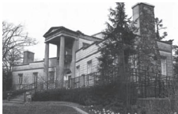
Abb. 2: Burritt Mansion, Huntsville, Alabama, USA, 1938. Der erste Holzständerbau, der mit ca. 2200 Strohballen für Wand, Decke und Dach als Wärmedämmung ausgefüllt wurde.
