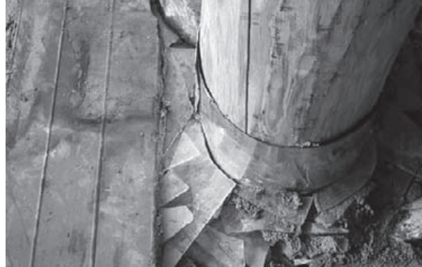
Abb. 28: „Spezialabdichtung“ an aufsteigenden Hölzern
