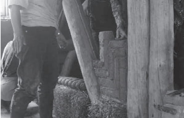
Abb. 31: Lehmwand, unten Ballen der Bodendämmung
