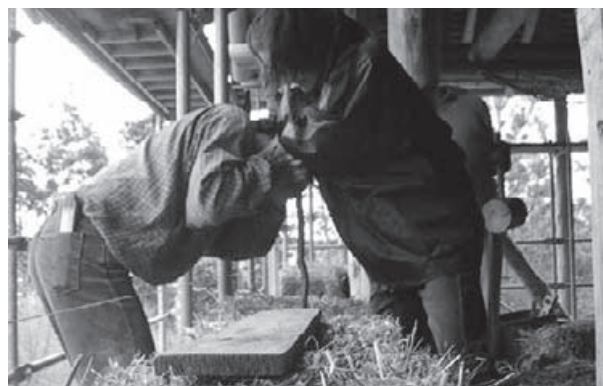
Abb. 22: „Vernageln“ der Strohballenlagen
