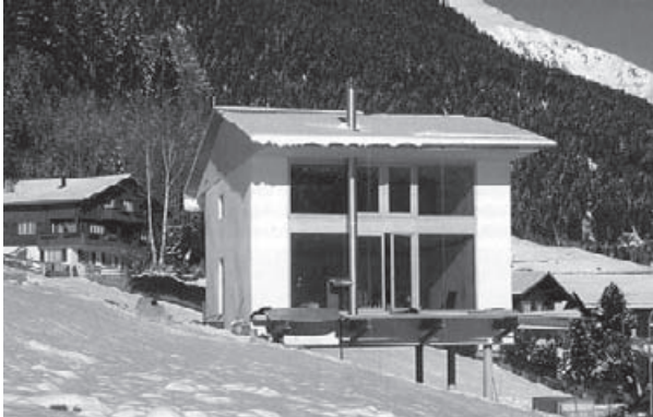
Abb. 10: Lasttragendes Strohballenhaus in Disentis, Schweiz
