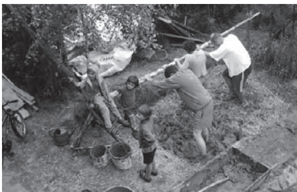
Abb. 20: Mischen von Lehm, Wasser und Stroh
