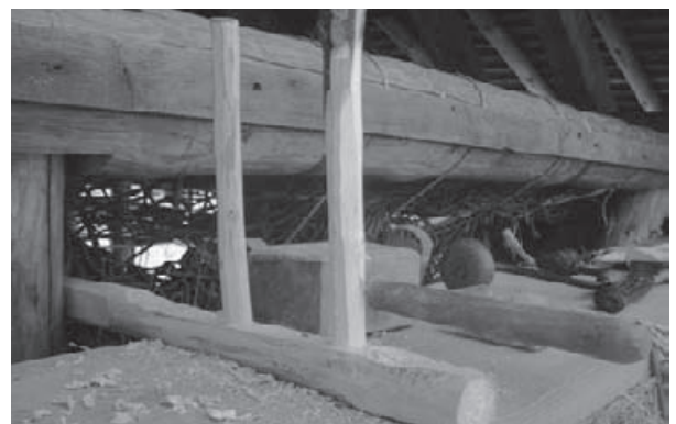
Abb. 25: Verankern der Wand an der Ständerkonstruktion
