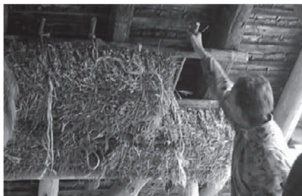
Abb. 30: Befestigung der Dämmung im Dachbereich
