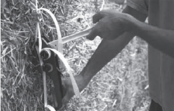
Abb. 8: Komprimierung mit LKW-Gurten
