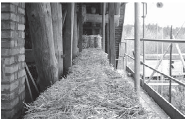
Abb. 21: Rohe Strohwand, links tragende Holzkonstruktion
