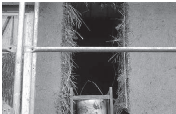
Abb. 29: Ausgesägtes WC-Fenster
