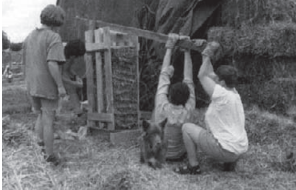
Abb. 23: Komprimierung mittels einfachster Geräte
